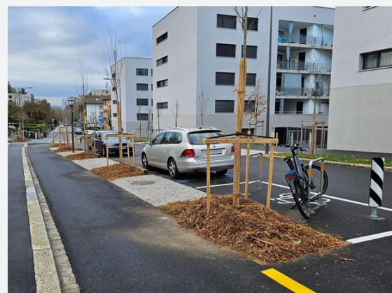
Désimperméabilisation et arborisation à la Route du Pavement à Lausanne
